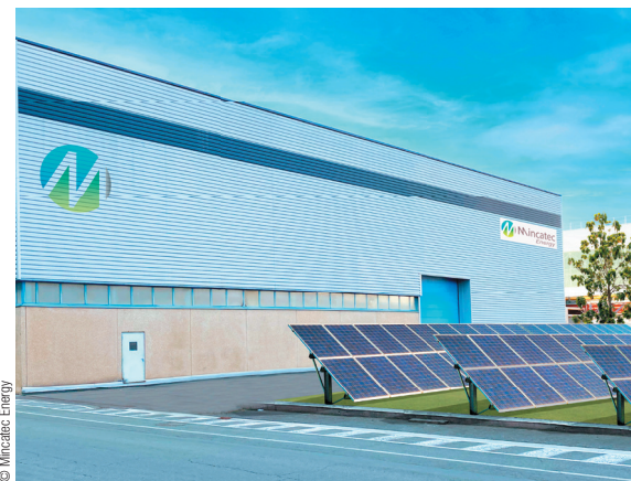
Inauguration en février 2022 des nouveaux ateliers à Belfort
